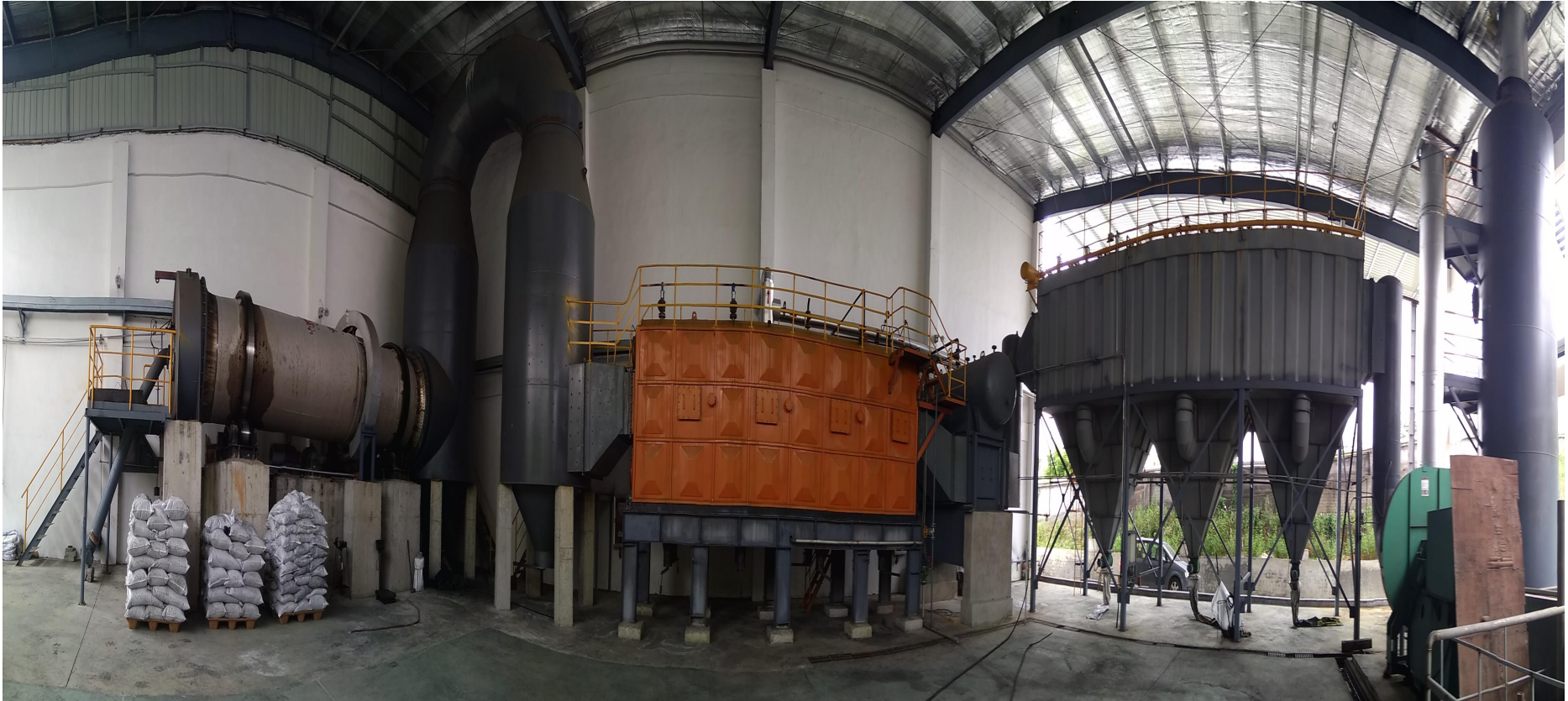
项目主体工程
